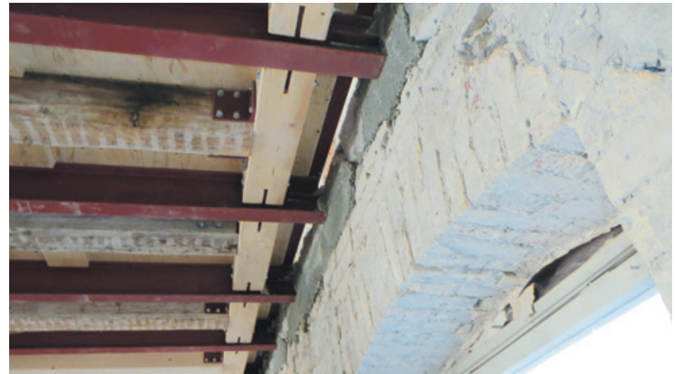
Ertüchtigung der Holzbalkendecke mit zusätzlichen Stahlträgern
