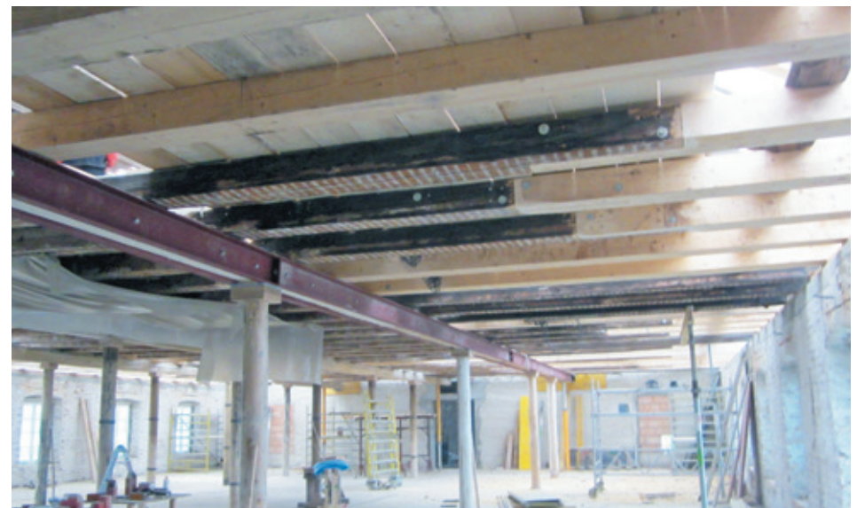
Instandsetzung der Decke unter Nutzung der vorhandenen Holzstützen und Deckenbalken
