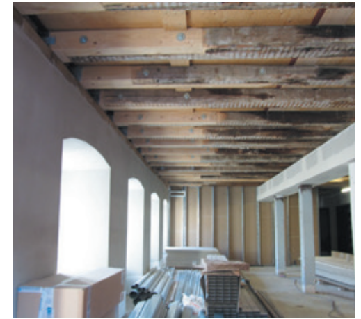
Zimmermannsmäßige Sanierung der Deckenbalkenköpfe mit stehendem Blatt
