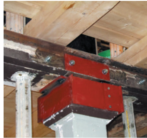
EG - Montierte Stützenkopf-ertüchtigung
