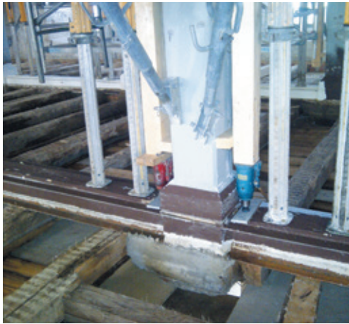
Rückverformung Stützensenkung mittels Hydraulikpressen und freistehender Stützenkopf
