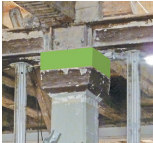
Rückverformung Stützensenkung mittels Hydraulikpressen und freistehender Stützenkopf
