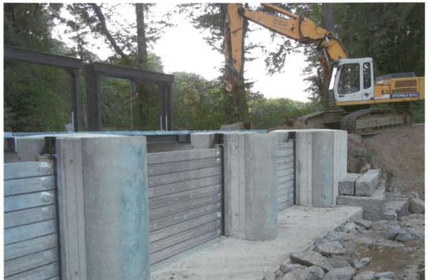
Bild 5. Wehranlage Zabeltitz mit UHPC-Vorsatzschalen
